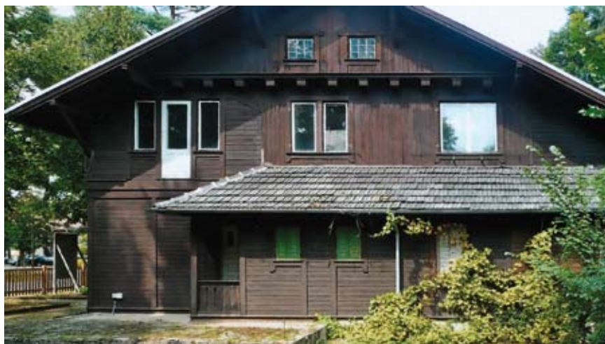
Scharwenka Haus 2008 Seitenansicht Süden
