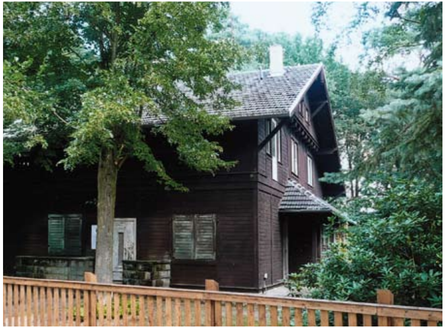
Scharwenka Haus 2008 Straßenansicht
